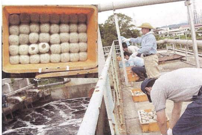
浄化施設の底部に EM を定着させ、ヘドロ分解目的で EM 醗酵させた泥ダンゴ 3,000 個を投入。今後も引き続き行い累計で 30,000 個を計画。
