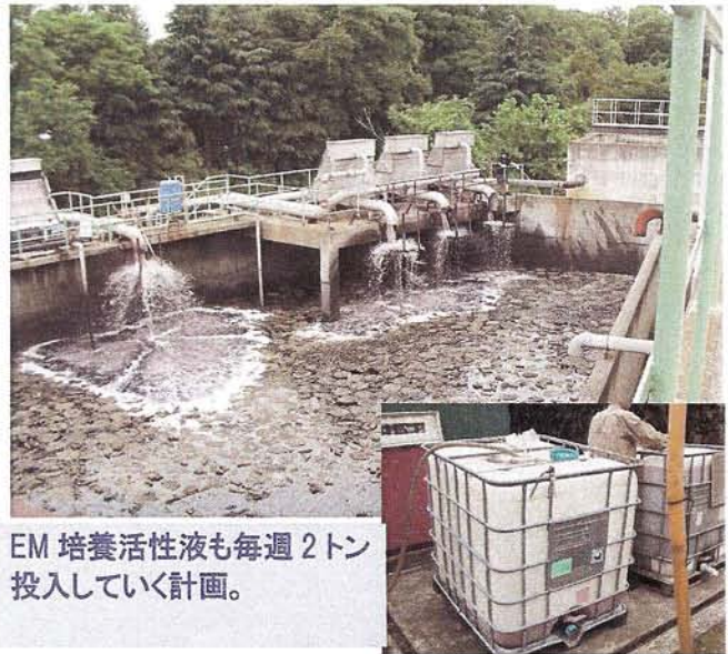
浄化施設の底部に EM を定着させ、ヘドロ分解目的で EM 醗酵させた泥ダンゴ 3,000 個を投入。今後も引き続き行い累計で 30,000 個を計画。
